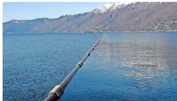
Aus dem Bildarchiv der Wasserbaufirma: Abschnitte liegen in einem schwimmenden Rohrlager bereit (links), und eine Leitung ist mit Betonelementen beschwert und wartet auf die Absenkung.
