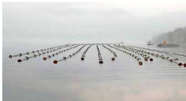
Aus dem Bildarchiv der Wasserbaufirma: Abschnitte liegen in einem schwimmenden Rohrlager bereit (links), und eine Leitung ist mit Betonelementen beschwert und wartet auf die Absenkung.
